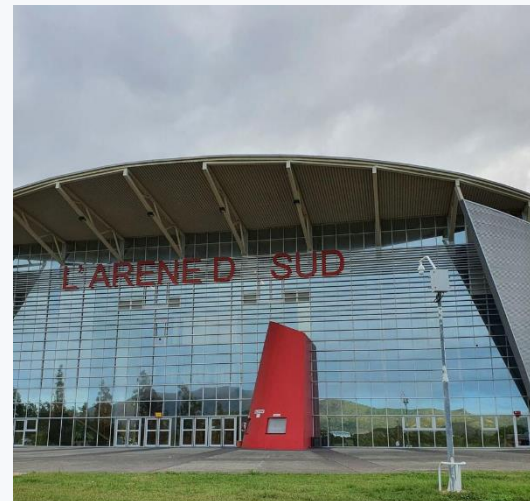
L'ARÈNE DU SUD Arena du Sud, Païta © 2015
